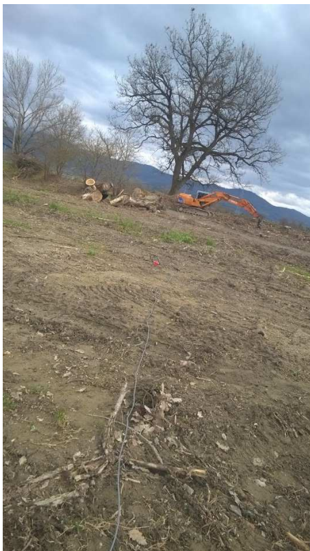
Misure in array sulla spalla B in sinistra Tevere
