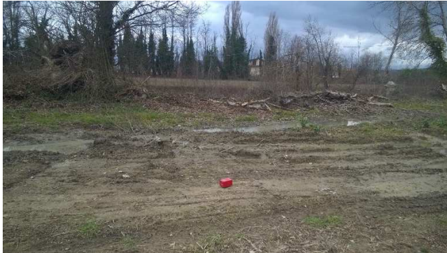
Misure a stazione singola sulla spalla B in sinistra Tevere
