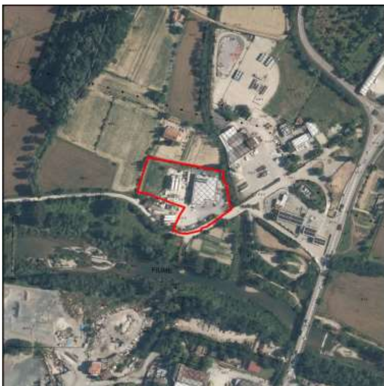
Estratto della foto aerea in cui è perimetrato in rosso l'ambito oggetto di variante di cui alla istanza n. 09
