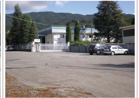
Zona Industriale Fiumicello
