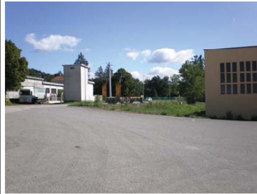
Zona Industriale Fiumicello
