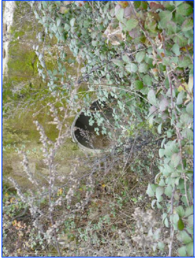
Ingresso \phi 1000 attraversamento in loc. Campezzone (vista da monte)
