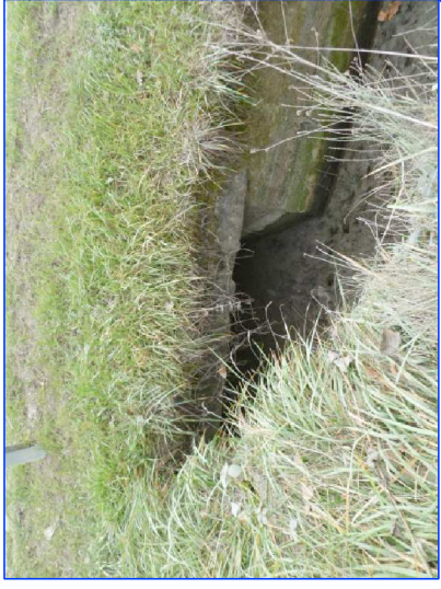
Ingresso manufatto di attraversamento di via dei Tarlati (vista da monte)
