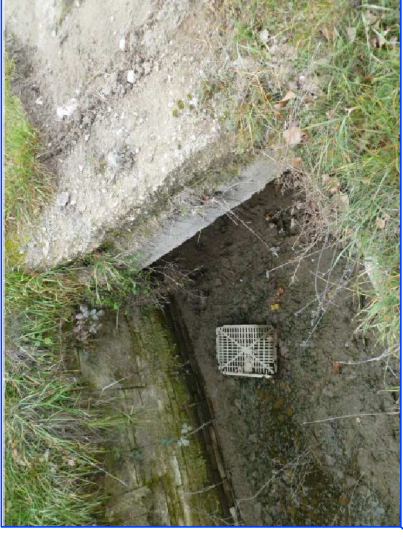
Uscita manufatto di attraversamento di via dei Tarlati (vista da valle)
