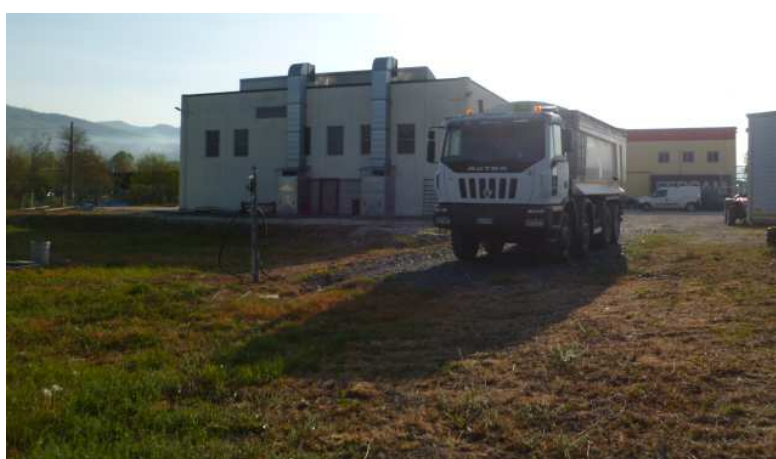
Fabbricato secondario e rilevato SUPERCAR s.r.l. (lato Ovest)
