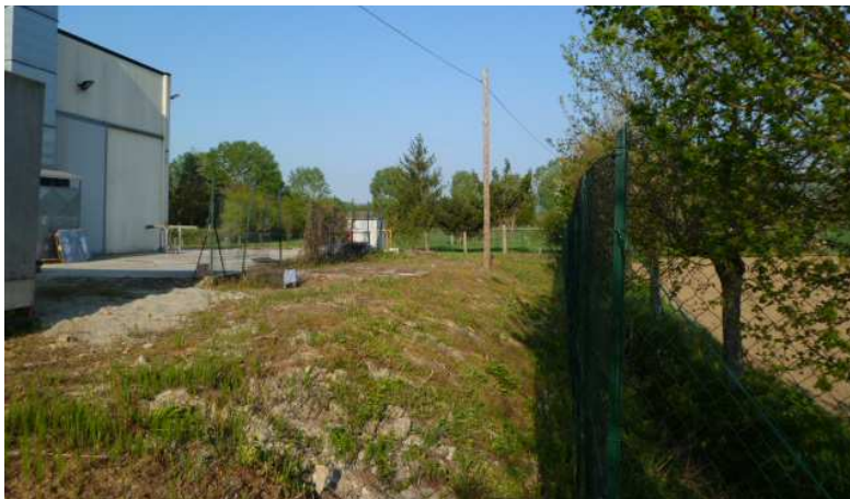
Fabbricato secondario e rilevato SUPERCAR s.r.l. (lato Nord)
