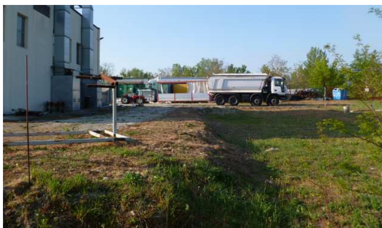
Fabbricato secondario e rilevato SUPERCAR s.r.l. (lato Nord Ovest)
