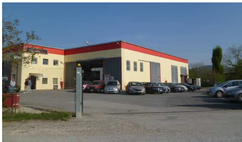
Fabbricato principale e piazzale SUPERCAR s.r.l. (lato Sud Est)
