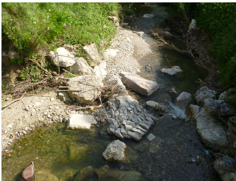
Torrente Fiumicello – Il tratto a ridosso della confluenza nel Tevere
