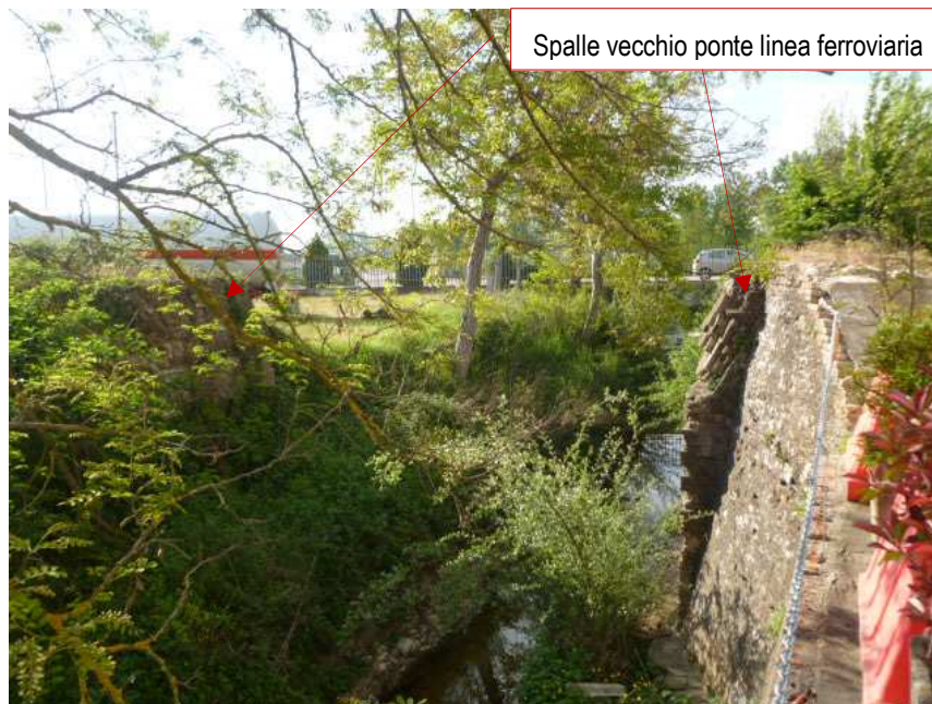
FOTO 2 Tratto del T. Fiumicello in prossimità delle spalle del vecchio ponte della linea FAC
