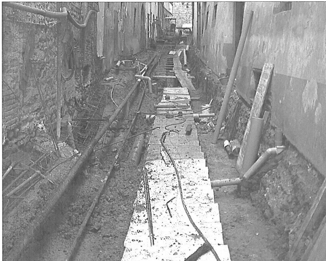
Lavori di sistemazione di Via Gherardi, eseguiti dall' Amministrazione Comunale, realizzando fra l'altro la doppia linea acque nere ed acque bianche.
