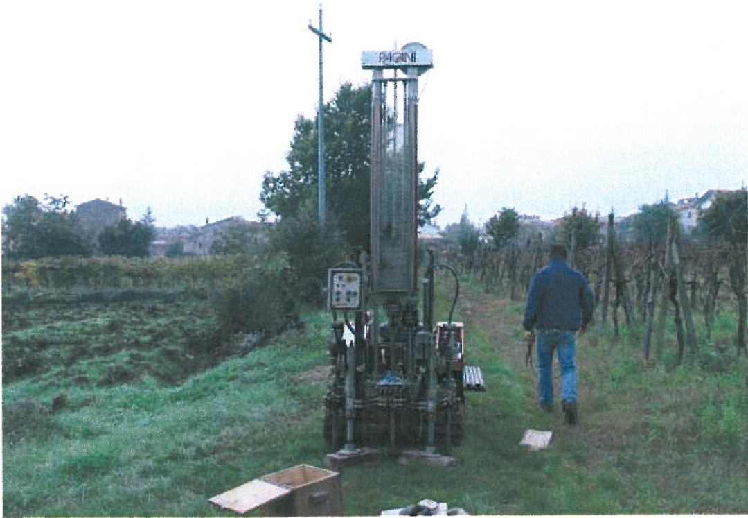
FOTO 1 : Strumentazione utilizzata per l'esecuzione della prova CPT 2.
