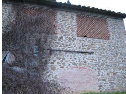
Il fronte sud dell'edificio n. 2 (fienile)
