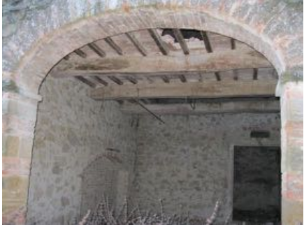
Particolare del piano terra dell'edificio n. 2 (fienile)
